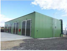
Voie garage Métha Guilbaud (44) 55 kWé
